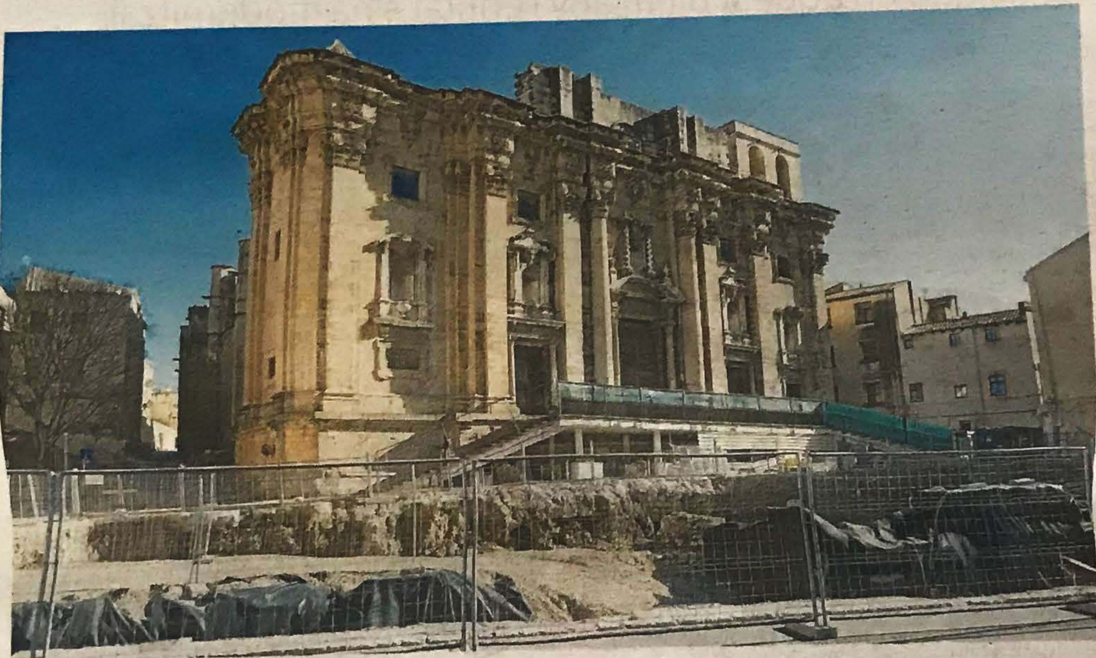
Les obres a la plaça de davant la catedral de Santa Maria, aturades. FOTO: JOAN REVILLAS
