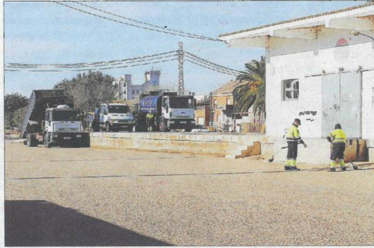
La nova via verda resseguirà l'antiga via de tren.
