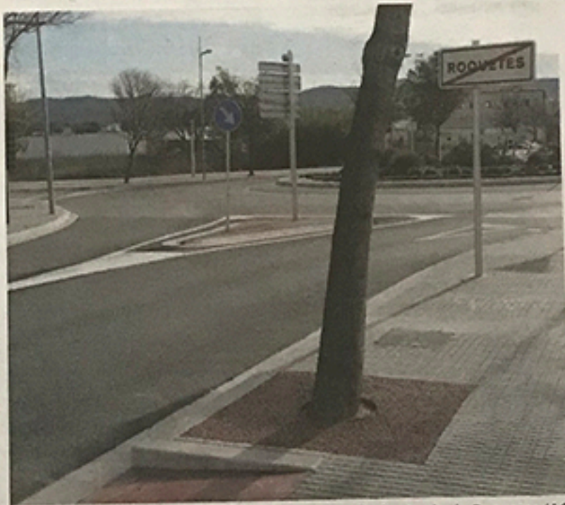
Arbre amb nou escocell a l'entrada de Roquetes (AC)
