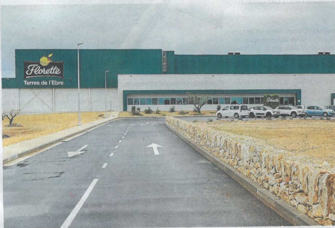
Les instal·lacions de Florette al polígon Catalunya Sud. FOTO: JOAN REVILLAS
