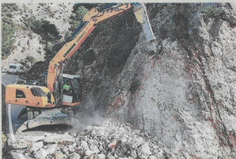
Detall de l'excavadora treballant al revolt. FOTO: DIPUTACIÓ DE TARRAGONA
