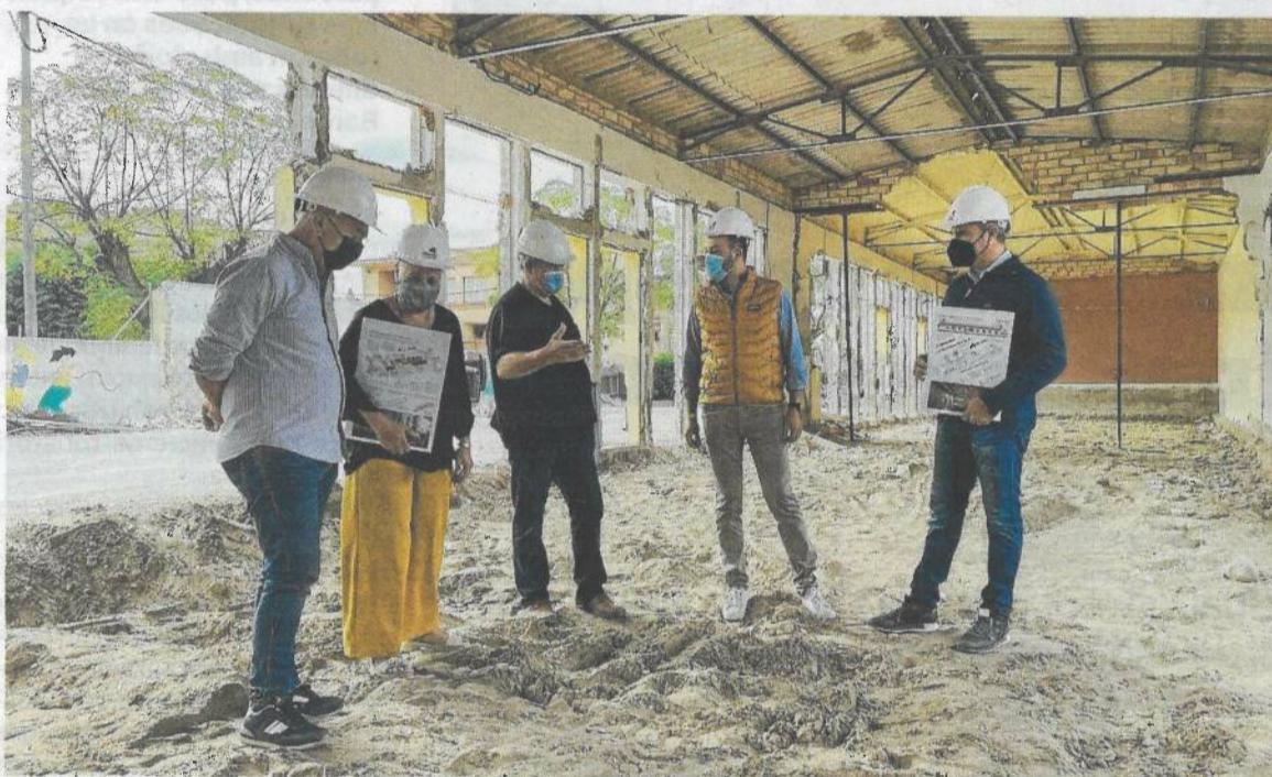
Visita a les obres que s'estan executant. FOTO: AJUNTAMENT DE DELTEBRE
