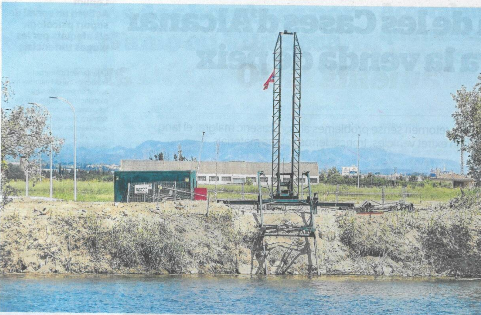
La marina seca s'està construint entre els terrenys de l'empresa Saica Pack i el pont penjant. FOTO: JOAN REVILLAS
