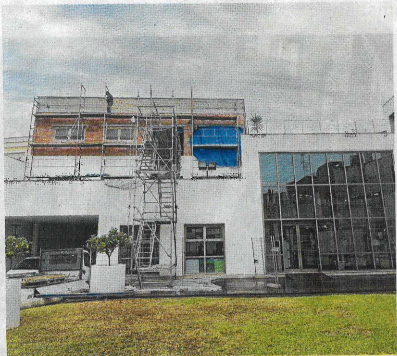
Obres en marxa a l'equipament. FOTO: JOAN REVILLAS
