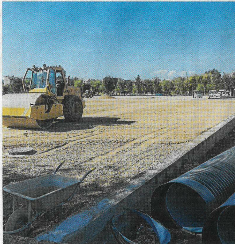
El solar on estava ubicat el pavelló. FOTO: JOAN REVILLAS
