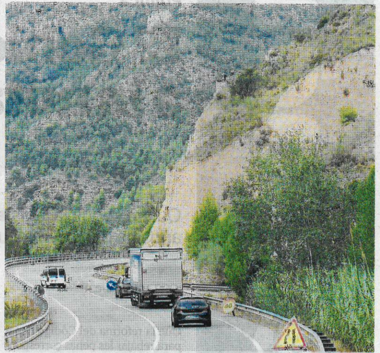
Les obres en marxa a la C-12. FOTO: JOAN REVILLAS
