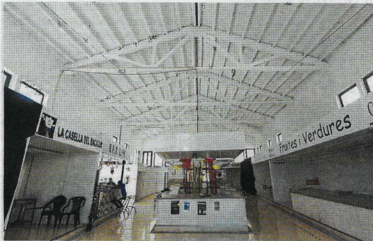
Estat actual de l'interior del mercat municipal de Roquetes. FOTO: JOAN REVILLAS
