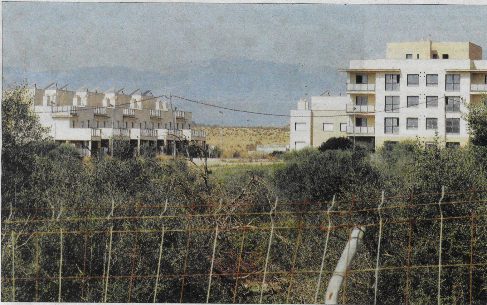
Un conjunt d'adossats i un bloc de pisos gairebé acabat, tots deshabitats, 15 anys després que s'aturessen les obres del Mirador del Ebro. / ANDREA CAPILLA
