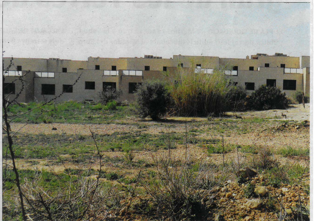
Panoràmica d'un conjunt d'adossats pendents d'acabar -s'hi poden detectar dos conills- i, a dalt, a la dreta, altres detalls de la urb
