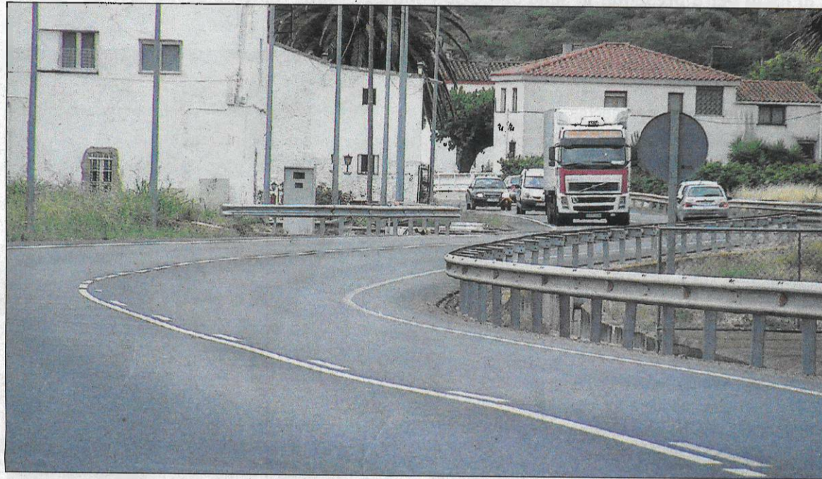
Imatge de la carretera de la C-12, a l'altura de Vinallop.
