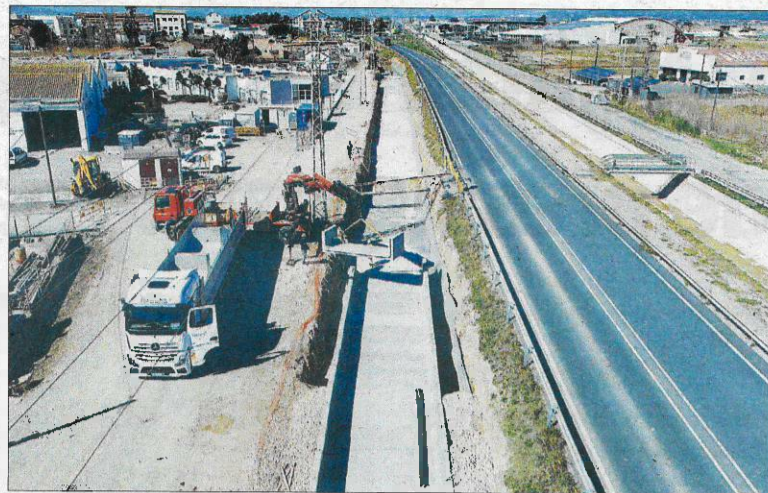
Imatge dels treballs de construcció del passeig del Carrilet de Deltebre. /CEDIDA
