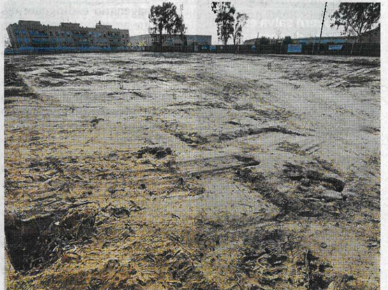
Estat actual de l'actuació al camp de futbol. FOTO: JOAN REVILLAS
