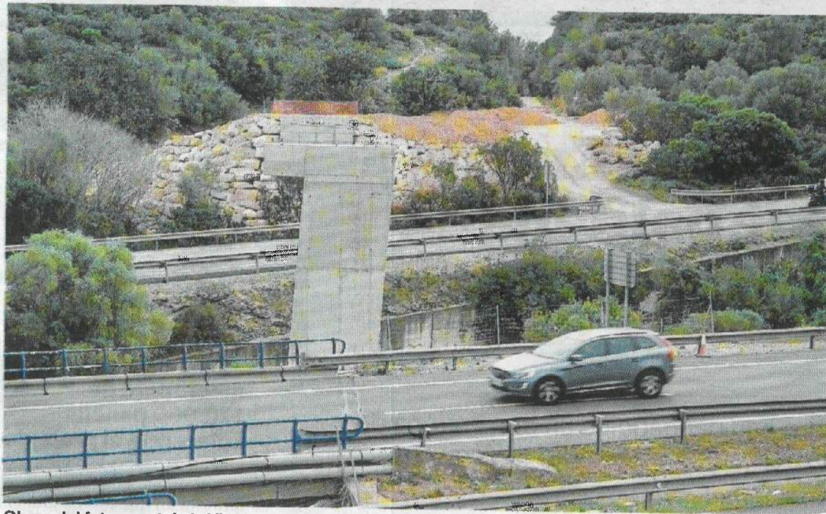
Obres del futur pont de la Via Verda a Amposta, sobre la C-12 i l'AP-7. FOTO: JOAN REVILLAS
